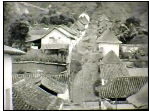
Foto antigua Calle del Espinazo
