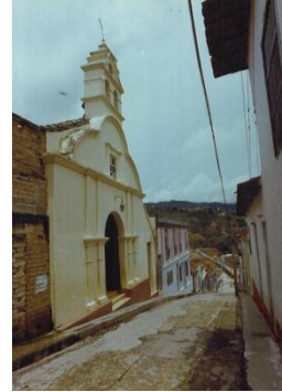
Iglesia de Santa Rita en la "Bajada de Santa Rita", carrera 9 entre Calles 9 y 10
